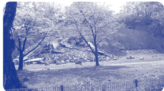
▲熊本城の石垣崩落
