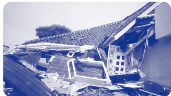
▲倒壊している家屋
