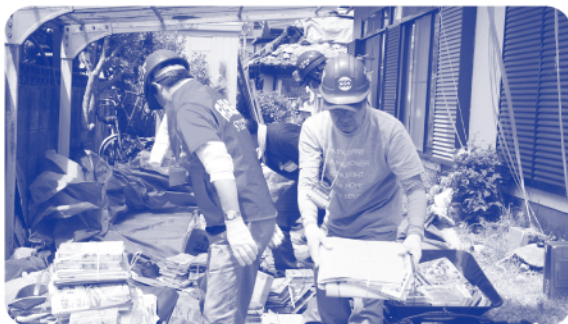
▲連合ボランティアの作業状況
