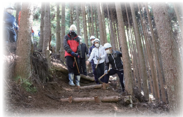
▲完成した歩道
